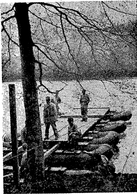
התקנת גשר קל על גבי מצופים (סירות פנוימטיות) מאפשר מעבר כלירכב במשקל עד 2.5 טון
