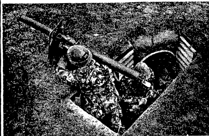
הבריטים משתמשים בכלי חפירה מכני "אטלס" או ב"הלמן-קידוח" — ביחד עם חומר-נפץ — לשם התחפרות בשטח סלעי.
