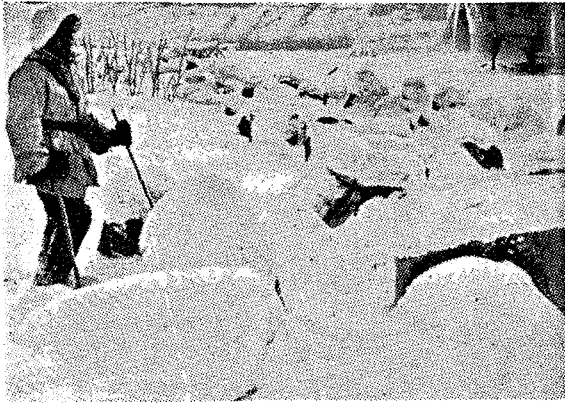
במכשולים נגד-טנקיים חברו יחד טבע ודי-אדם. סיר-רגל פני צופה אל מעבר לדפנות, "שיני-דקון" במיצור הקרלי — גושי גרניט מכוסים שלג.
