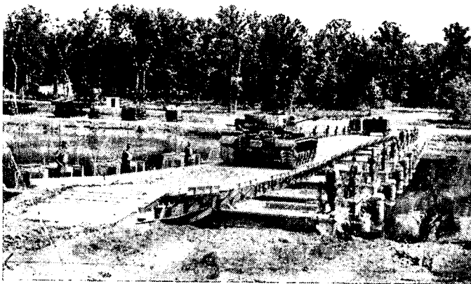
תמונה מס' 4: גשר זה, שאורכו 100 מטרים, מורכב מ-10 יחידות רגילות ו-2 יחידות כבש. הוא מוקם תוך 15 דקות, על ידי 36 אנשים. בתמונה נראים טנק בן 47 טונות ונגמ"ש בן 17 טונות עוברים על הגשר וממחישים את כושר המעמס שלו.
