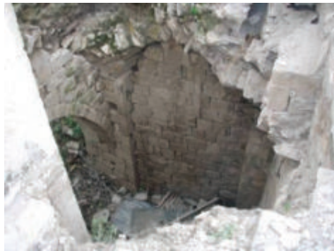
חיתוך של קיר מבנה בעיר העתיקה שעשוי ממלט של שברי אבנים דחוסים בין שני קירות אבן המקור, הנדסה חטמ"ר שומרון
