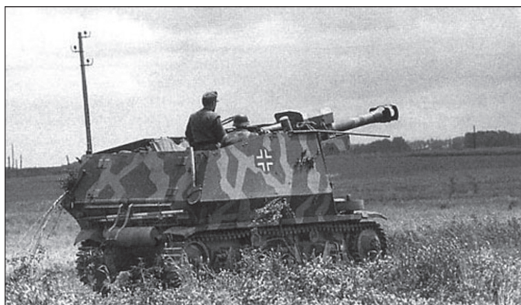
תותח מתנייע גרמני מדגם ג'וֹוֶןֶוֶןֶוֶן לֶוֶן שְׁלֶפֶר בעל תותח בקוטר 150 מילימטרים
