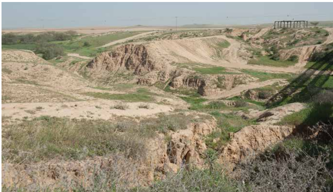
סוללת הרכבת הבריטית רפיח-באר-שבע בנחל אופקים. עליה היה נטוי גשר עץ זמני. צילו של גשר הברזל הקבוע, שנבנה בתום הקרבות, נראה מימין. מבט לצפון | צילום: בר קריאף
