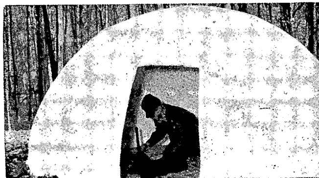
אהל-איגלו" טלטיס, עשוי חומר פלסטי המותז על גבי כיפת-בר מנופחת. עומד בפני תלאות מזג-אוויר.
