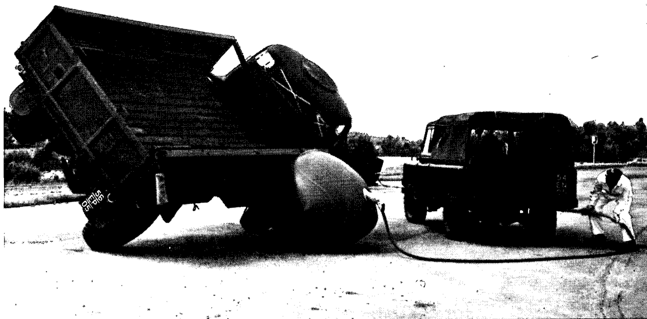
מגבה מתנפח בשימוש הצבא הבריטי. הוא מסוגל להרים קרון או משאית שהתהפכו.
